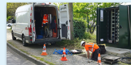
↑ Chantier déploiement fibre optique
