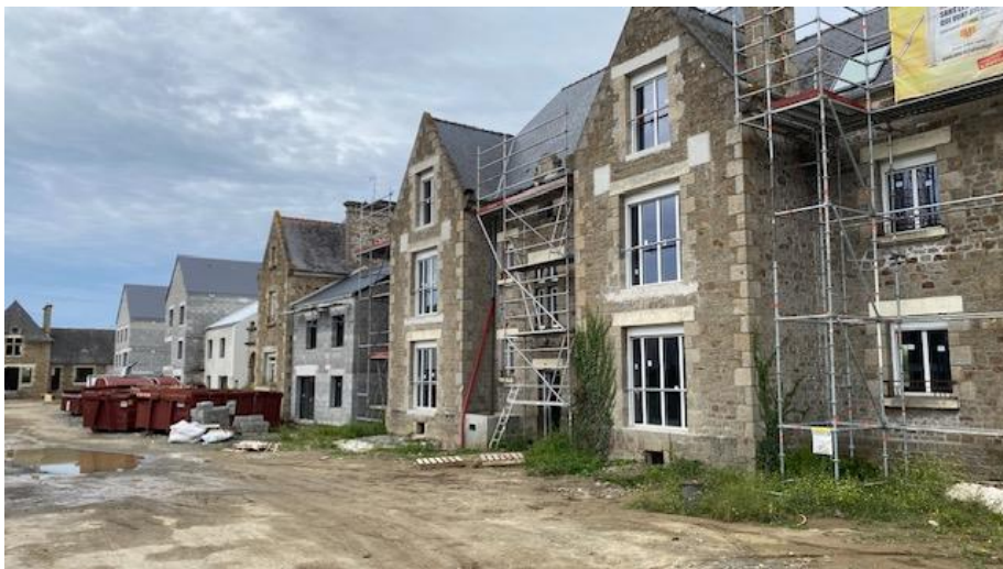
Illustration 16 : Constructions nouvelles et réhabilitations pour la création de nouveaux logements dans le cadre du projet de renouvellement urbain de Lorette à Saint-Malo
