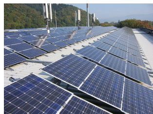
Les toits du stade de Football
